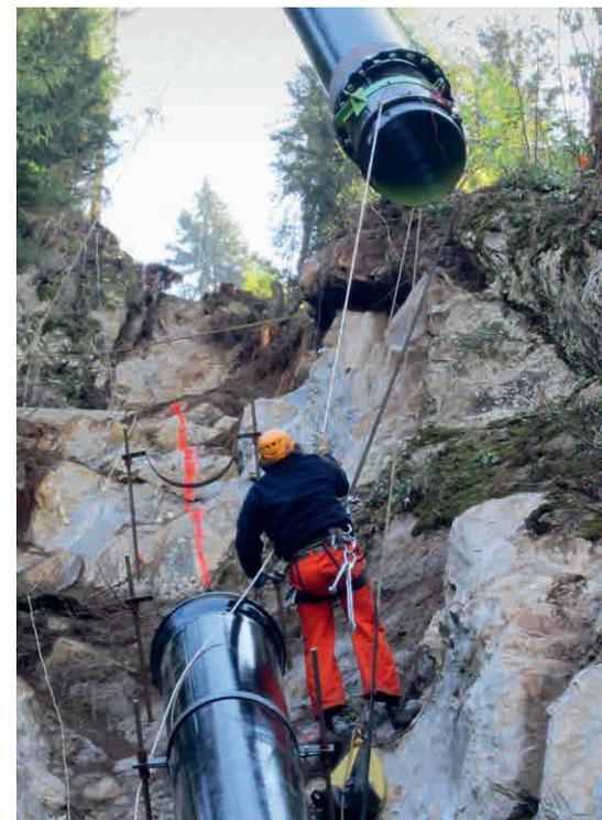
Montaggio della condotta forzata per l'esercizio di una centrale idroelettrica in Ticino
