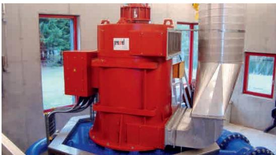
Generatore completamente montato presso la centrale idroelettrica VAL STREM/GR
