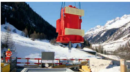
Montaggio del generatore nella centrale idroelettrica di Ossasco/TI
