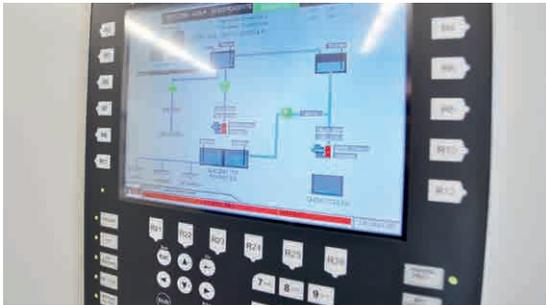
Moderna unità di controllo gestita da PLC per una microcentrale
