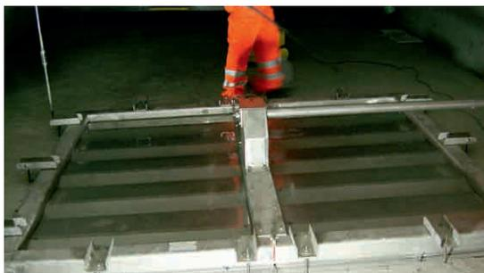
Montaggio di una cappa di aspirazione dei fumi nella volta della galleria
