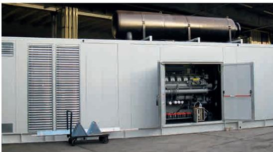
Lavori di montaggio di un gruppo elettrogeno d'emergenza in Ticino. Potenza superiore a 2 MVA
