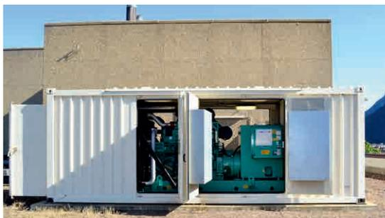
Gruppo elettrogeno d'emergenza da 850 kVA per la Banca dello Stato del Cantone Ticino, installato sul tetto dell'edificio
