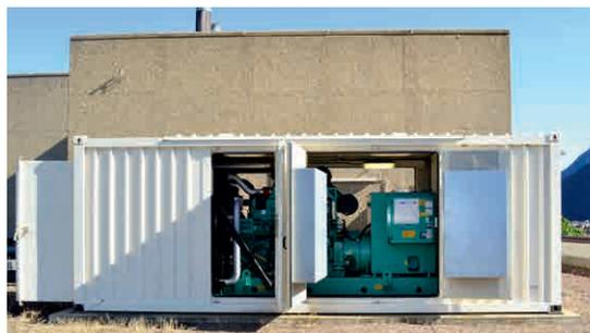
Gruppo elettrogeno d'emergenza da 850KVA per Banca dello stato del Cantone Ticino, installato sul tetto dell'edificio.
