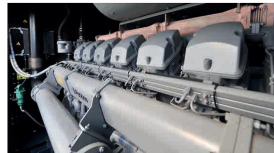
Aggregato diesel di un gruppo elettrogeno d'emergenza. Potenza superiore a 2 MVA
