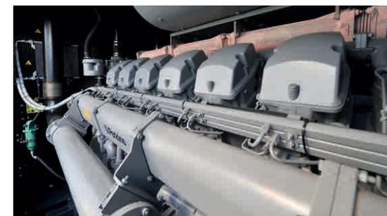
Motore diesel di un gruppo elettrogeno d'emergenza. Potenza superiore a 2 MVA
