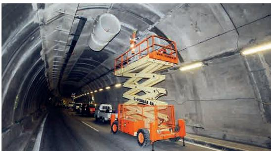
Montaggio di ventilatori sulla volta della galleria
