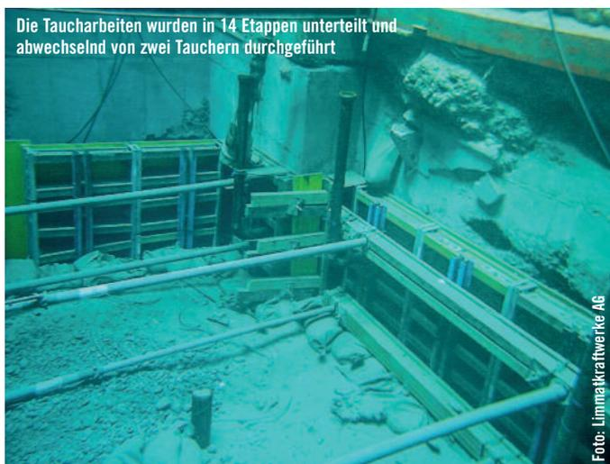
Die Taucharbeiten wurden in 14 Etappen unterteilt und abwechselnd von zwei Tauchern durchgeführt
