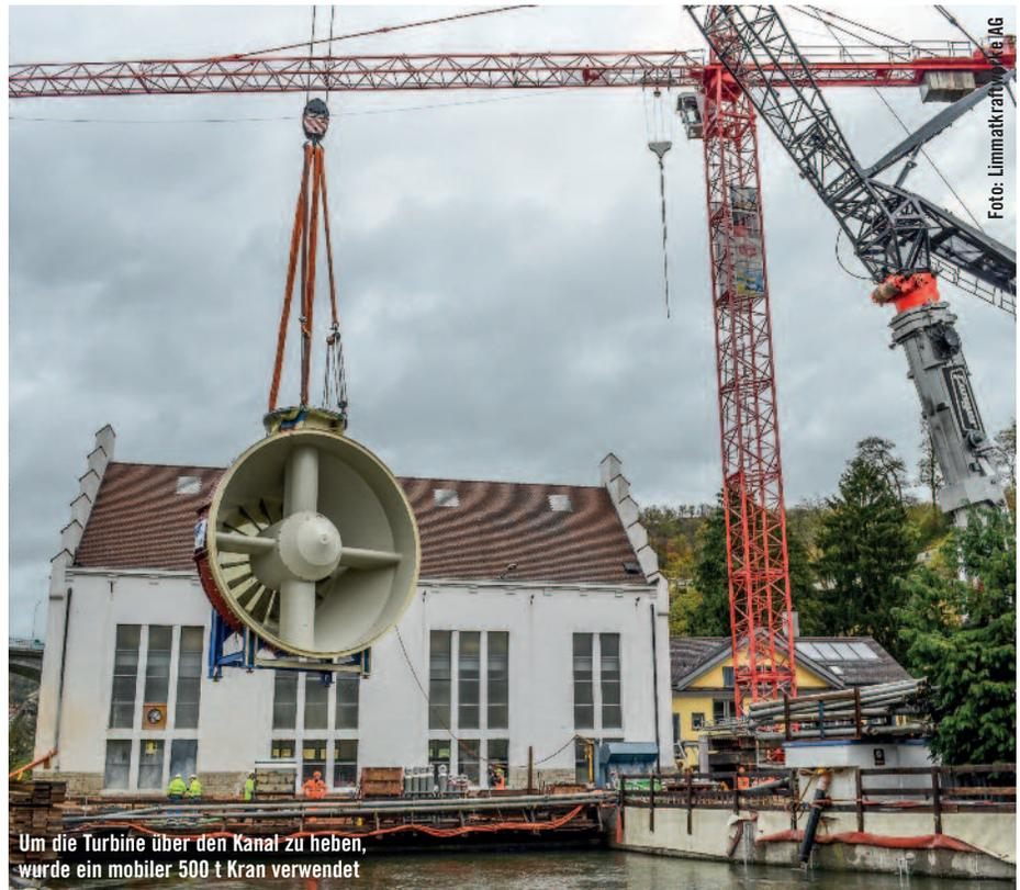
Um die Turbine über den Kanal zu heben, wurde ein mobiler 500 t Kran verwendet
