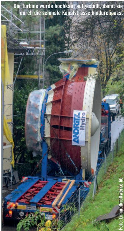
Die Turbine wurde hochkant aufgestellt, damit sie durch die schmale Kanalstrasse hindurchpasst
